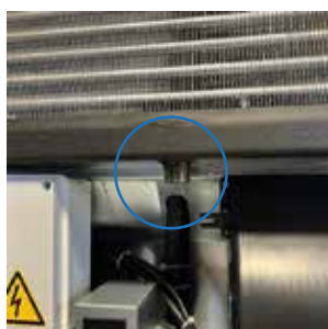
Attacco per lo scarico diretto della condensa
