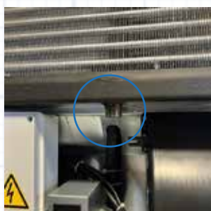
Attacco per lo scarico diretto della condensa
